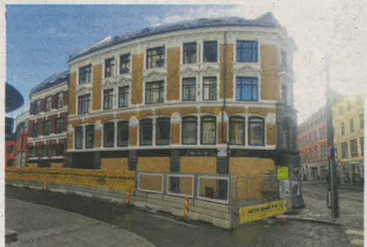
REHAB: Aktiv Bygg rehabiliterer Opsahl Eiendoms bygård i Pilestredet 12. FOTO: AKTIV BYGG
